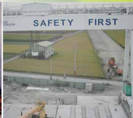
2001年台灣高速鐵路100噸門型吊車
