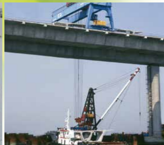
2004年VSL香港跨海大橋揚程50M門型吊車
