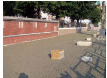
3) 透水混凝土載重層養護完成。
