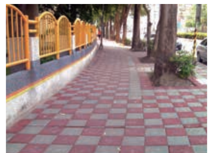
6) 人行道施工完成。
