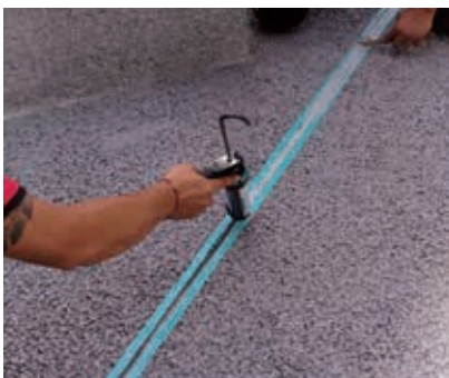
4) 伸縮縫上填縫膠及周邊防護。
