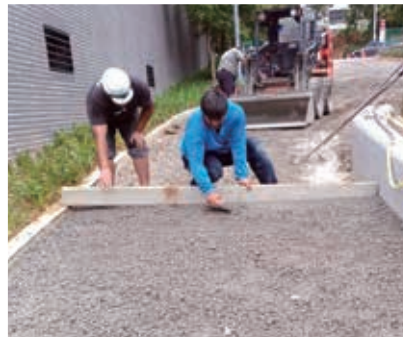
2) 路緣石安裝，高層確認，現場澆置透水混凝土。
