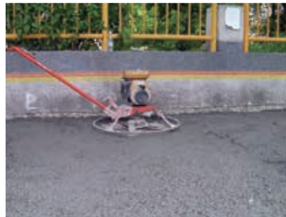
2) 透水混凝土載重層整平。
