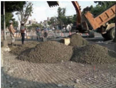
1) 透水混凝土載重層澆置。
