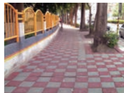
6) 人行道施工完成。
