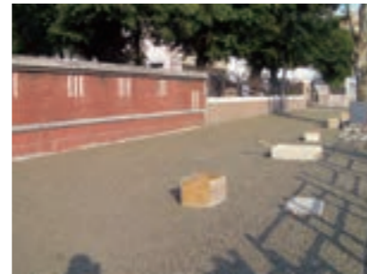
3) 透水混凝土載重層養護完成。
