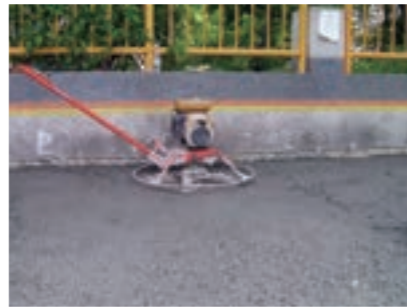
2) 透水混凝土載重層整平。
