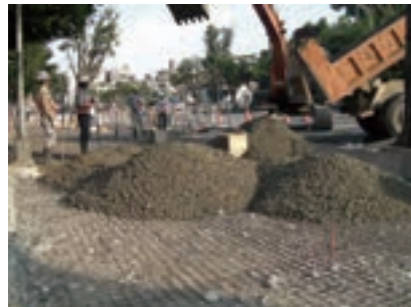
1) 透水混凝土載重層澆置。
