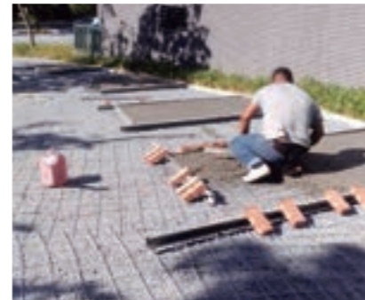
3) 鍍鋅點焊鋼絲網放置，伸縮縫按規畫施作，並以間隔分開的方式施作。
