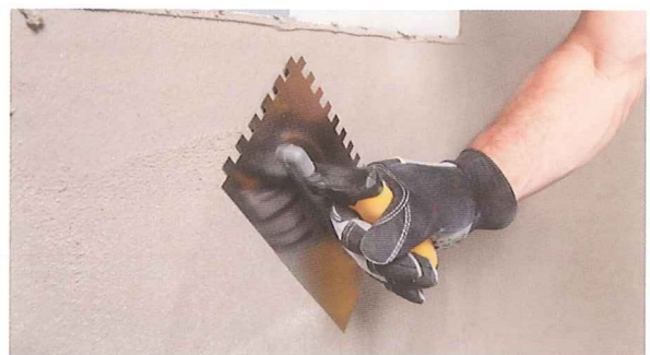
1 首先在白磚牆體上使用伊通介面劑進行打底。在高濕區域（廚房、浴廁等）需使用伊通防水介面劑進行打底
