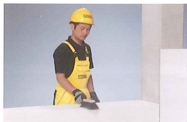
9 每一層砌築完成時都需要用毛刷清理乾淨
