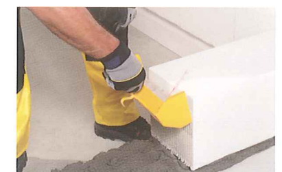
6 使用伊通刮勺，在白磚粘結處塗抹黏著劑
