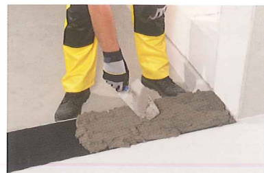
2 砌築第一層白磚前，使用水泥砂漿打底
