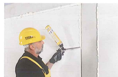
16 白磚牆體遇梁、柱、RC牆及天花交界處，以PU發泡劑填滿並將突出處切齊
