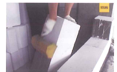
12 在白磚的底部和粘結處塗抹黏著劑，砌築牆體
