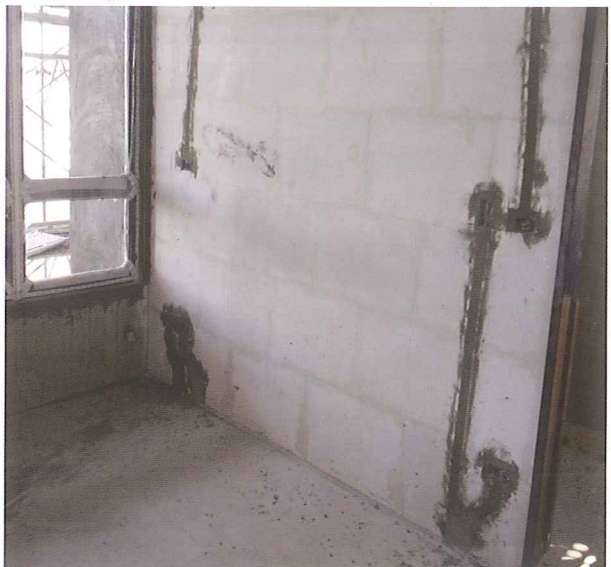
4 完成作業。按照伊通工法完成刨溝及配管作業後，方可進行批土及瓷磚貼附作業
