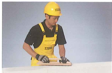
8 如果磚體有不平整的地方，需使用鋼尺磨板或磨砂板磨平
