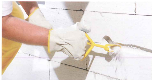
2 使用手持切割機沿管路及線盒位置切割後，使用攪槽器進行刨溝作業
