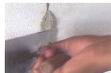
17 使用伊通修補材填補牆體破損處
