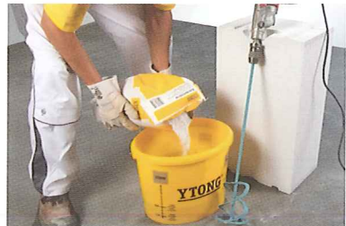
1 施工前，準備所需要的水泥砂漿和黏著劑
