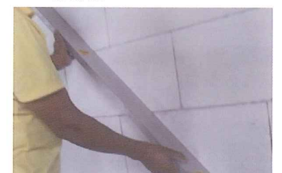
18 磨平牆面，並使用水準靠尺檢查牆體的平整度
