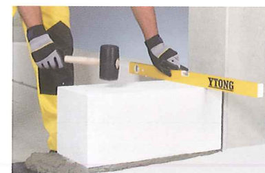
4 放置抗滲白磚在砂漿上，使用水準靠尺和橡皮錘將白磚調整至水準
