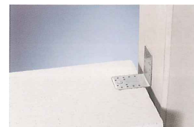
11 牆體與結構體交界處使用波浪形鐵件連接
