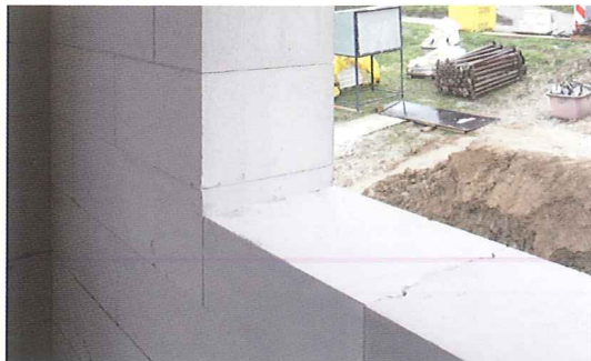
1 砌磚及磚補縫完成 2 天后進行水電管路刨溝配管作業
