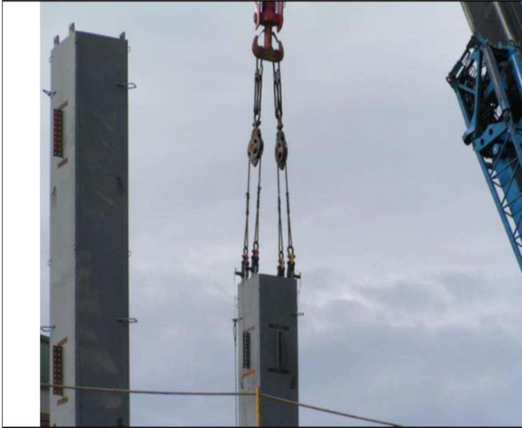
◎吊掛使用半自動脫鉤裝置，減少高處作業。
