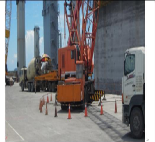
◎吊掛作業半徑內禁止人員進入。
