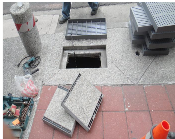
高雄市七賢路 & 南台路 「排水不良」- 化妝蓋板 替換
