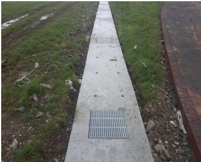
台北市 內湖 垃圾山安全設施
