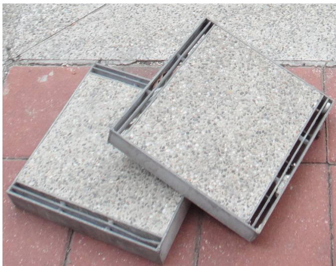
高雄市七賢路 & 南台路 「排水不良」- 化妝蓋板 替換
