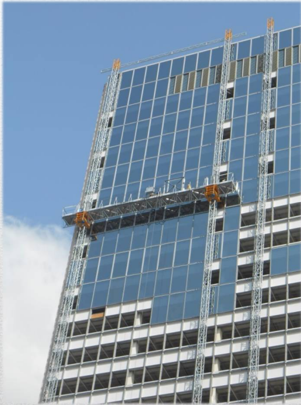
大樓玻璃面安裝
