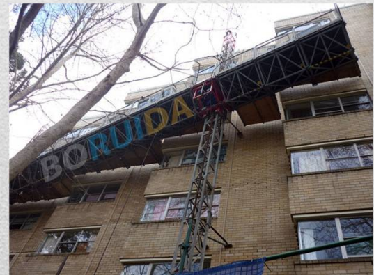
多角度建物使用狀況
