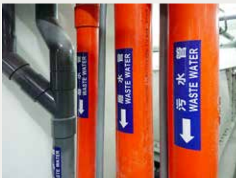
下水道工程 Sewer Engineering
