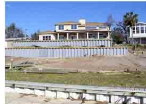
錨碇加固施工
