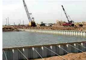
錨碇加固施工
